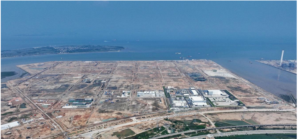
正在建设中的巴斯夫湛江一体化基地（2022 年 10 月拍摄）。
